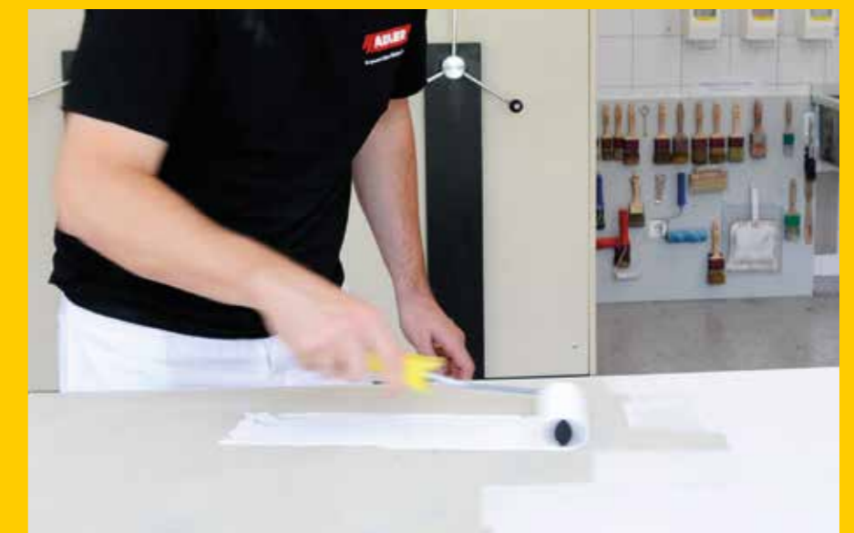
Grundieren – schnell und einfach
